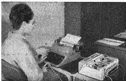
e la marcia normale del nastro; premendo a fondo il pedale avviene il riavvolgimento per il riascolto; togliendo la pressione del pedale, il nastro si ferma.
